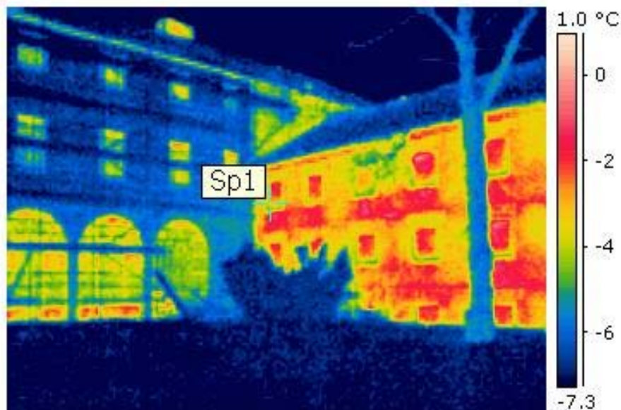
Abbildung 3-6 Thermografie des Exerzitienhauses /FFE 05/06/
