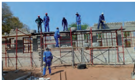
Fachkräfte beim Bau des Mädchenwohnheims
